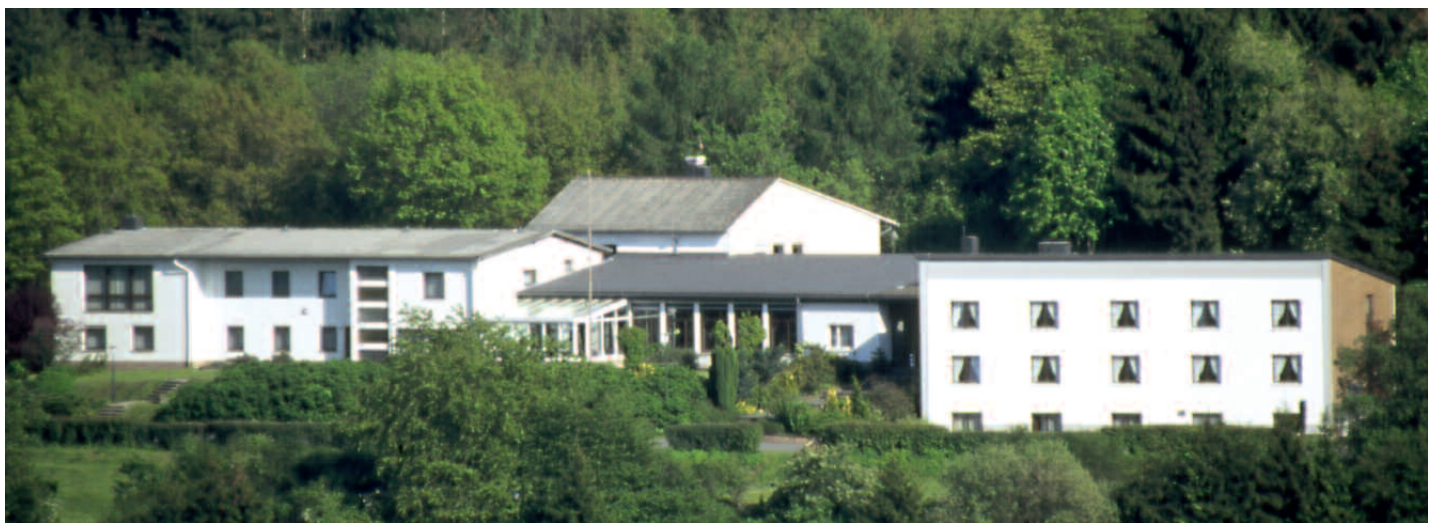
Die Gesamtansicht vom Freizeitheim steht für die zu erneuerten Dächer
